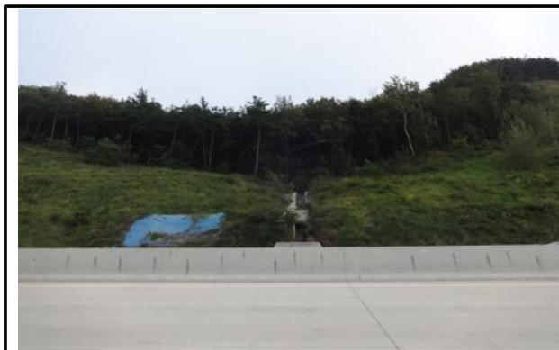
1단 임시보수 전경
